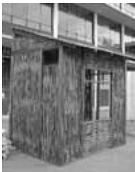
ENTRAMADO DE UN TELAR DE CAÑA. FACULTAD DE ARQUITECTURA URBANISMO Y ARTES DE LA UNIVERSIDAD NACIONAL DE INGENIERÍA. LIMA (PERÚ)
