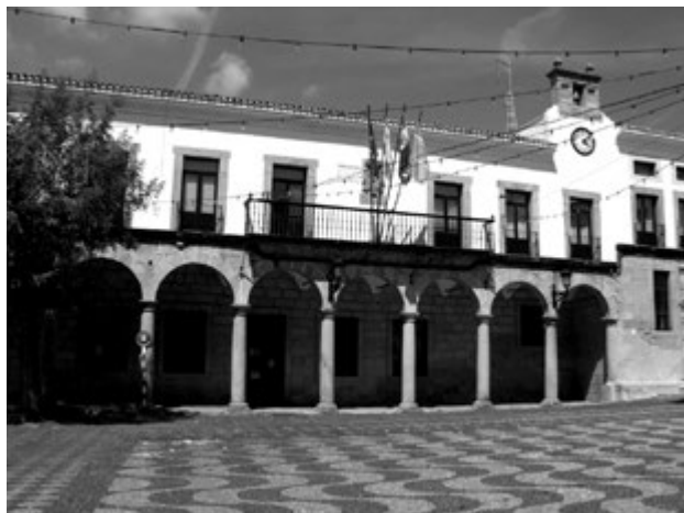
Lám. 2. Vista de los soportales construidos durante la reedificación de 1691.
