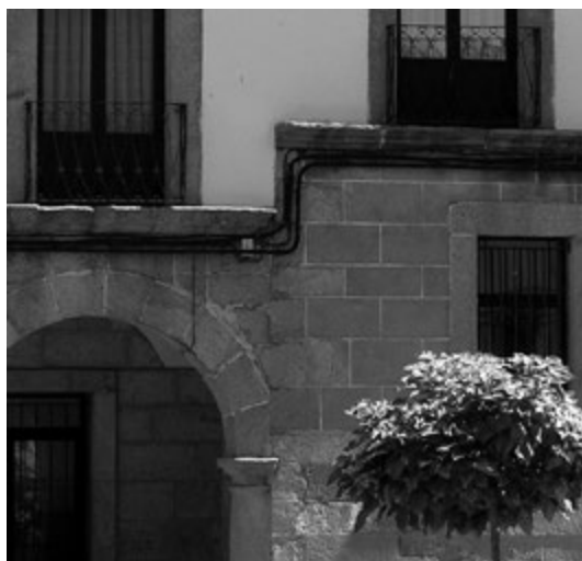
Lám. 3. Detalle de la forzada trabazón entre los soportales y el cuerpo de la carnicería.
