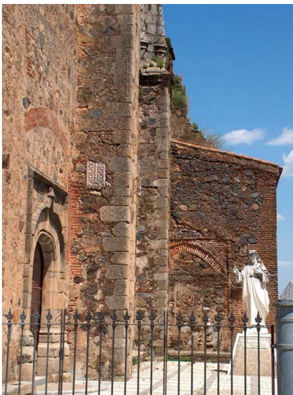
Fig. 6. Iglesia de San Blas. Vista lateral. Exterior.
