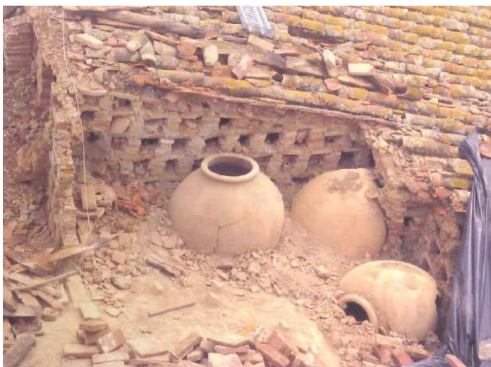
Fig. 8. Tabiques palomeros sobre el relleno cerámico.
