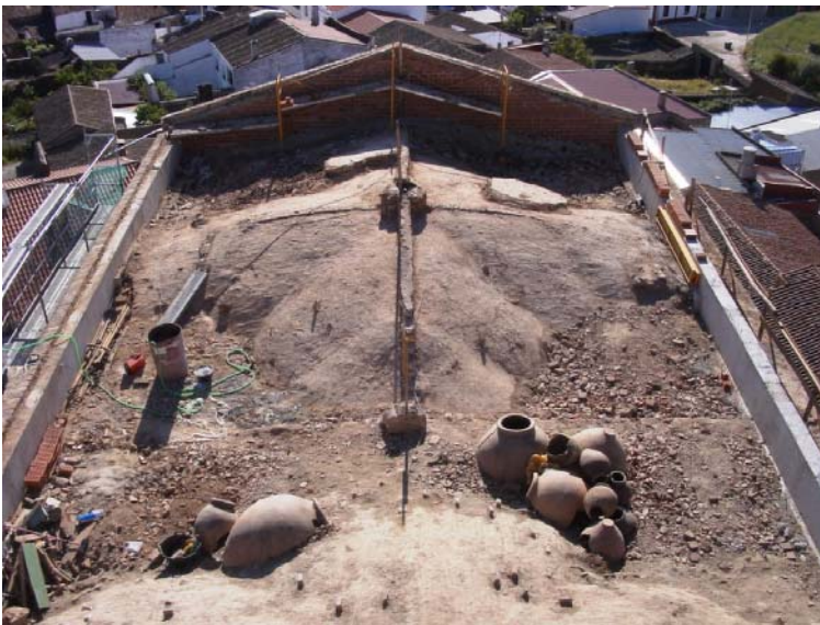
Fig. 7. Tinajas in situ del relleno de los senos de las bóvedas.
